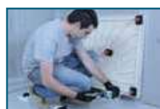
3 DISPOSER LES PIEDS ET INJECTER LA RÉSINE
