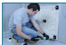
3 DISPOSER LES PIEDS ET INJECTER LA RÉSINE
